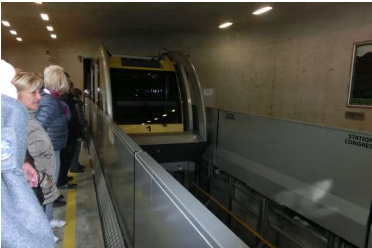
Arrivée du funiculaire en station : il est composé de 5 cabines qui se décalent en montée.
