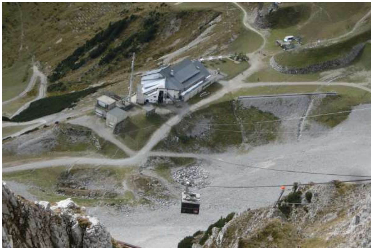
Montée vers Hafelekar 2256 m ; il n'y a qu'une cabine avec, sur le câble descendant, un contrepoids !
