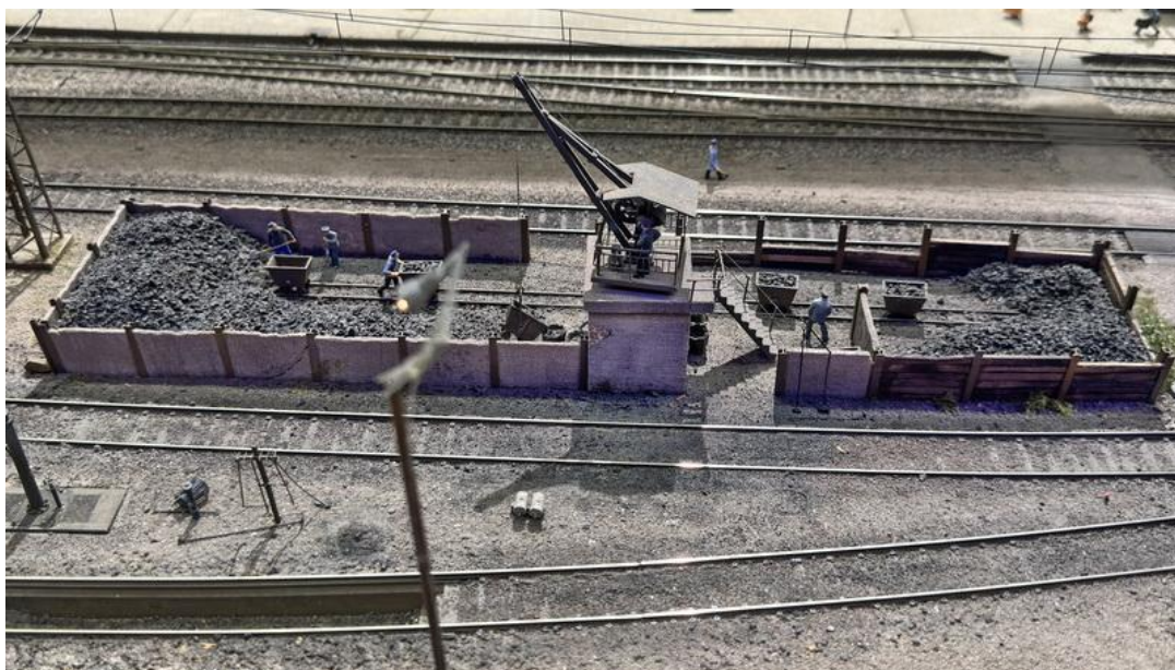
Le parc à charbon avec ses wagonnets
