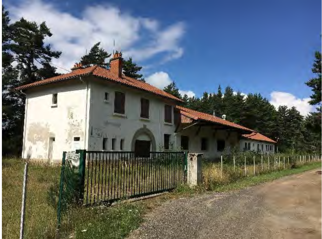
3. (Photo ci-dessus) la gare fantôme de Laussonne, qui a longtemps hébergé une colonie de vacances du CE SNCF (le 3e corps de bâtiment, au fond, est un ajout postérieur à l'édification par le PLM !)
