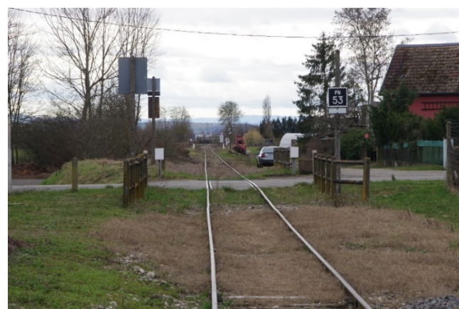
Entrée du centre de la commune de Bantzenheim (au PN 53, la D406 traverse la voie qui sera à partir de maintenant à l'W).
