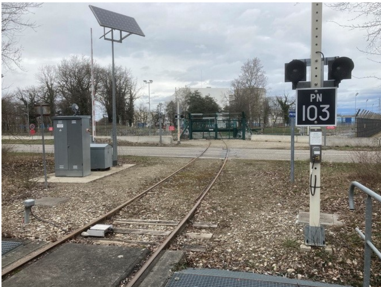
PN103 et entrée du CNPE de Fessenheim. A noter qu'avec le PN 101, ce sont les seuls PN de la ligne équipés de barrières et de signaux sonores et lumineux.
