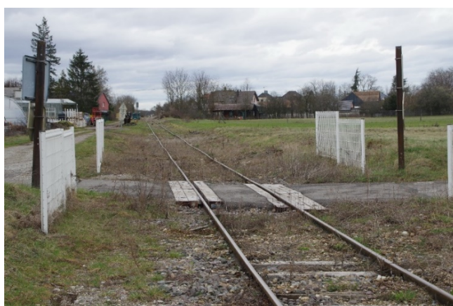
Ce même PN54 vue depuis la voie
